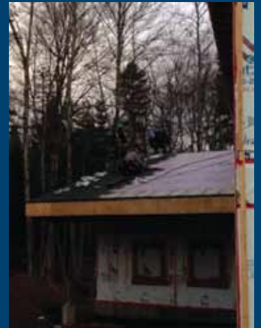
Début de la pose des bardeaux
