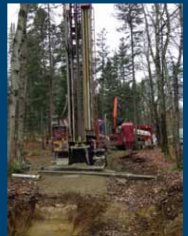
Forage du puits
