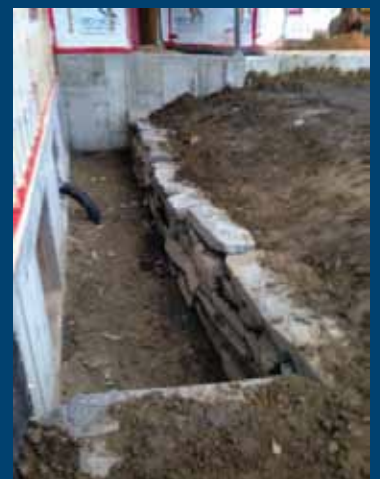
Margelles en pierre devant les fenêtres au sous-sol
