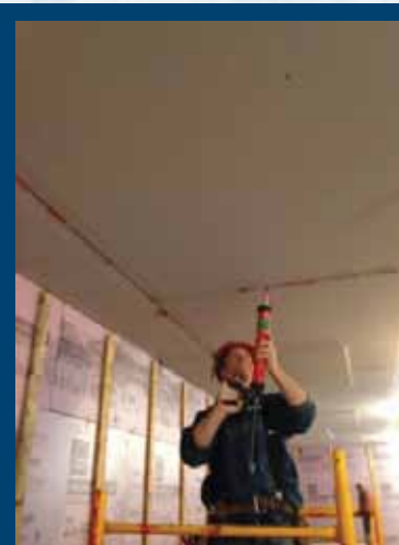
Installation du gypse au plafond du sous-sol
