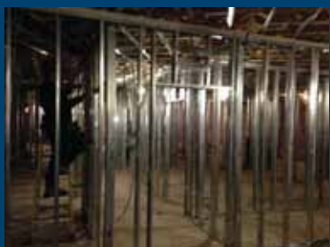
Cloison au sous-sol
